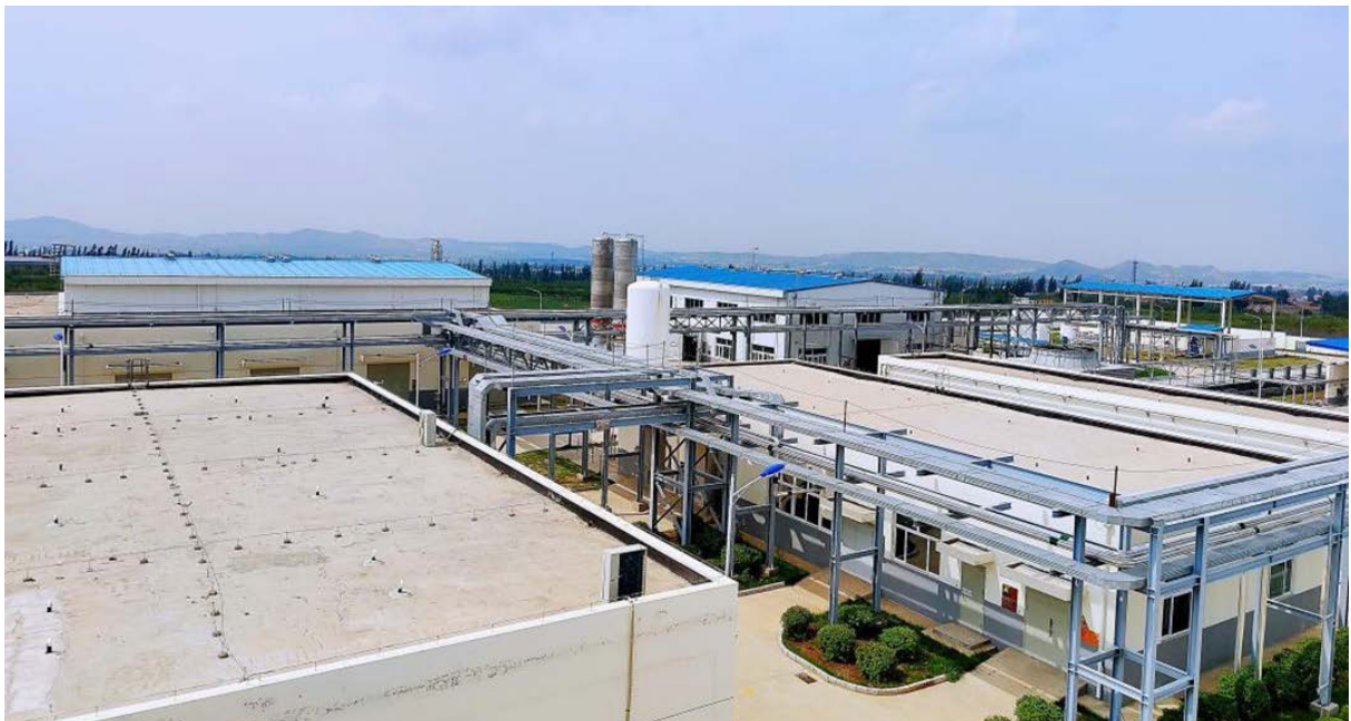
张家口氢能产业化应用示范园建设项目
