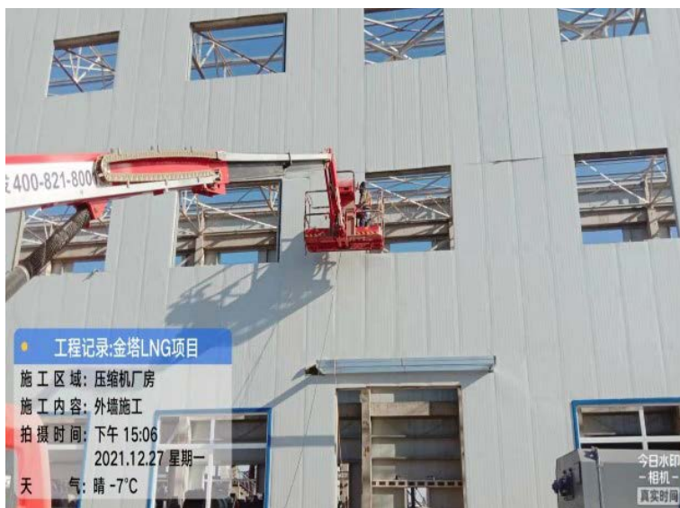
新地能源高空作业图
